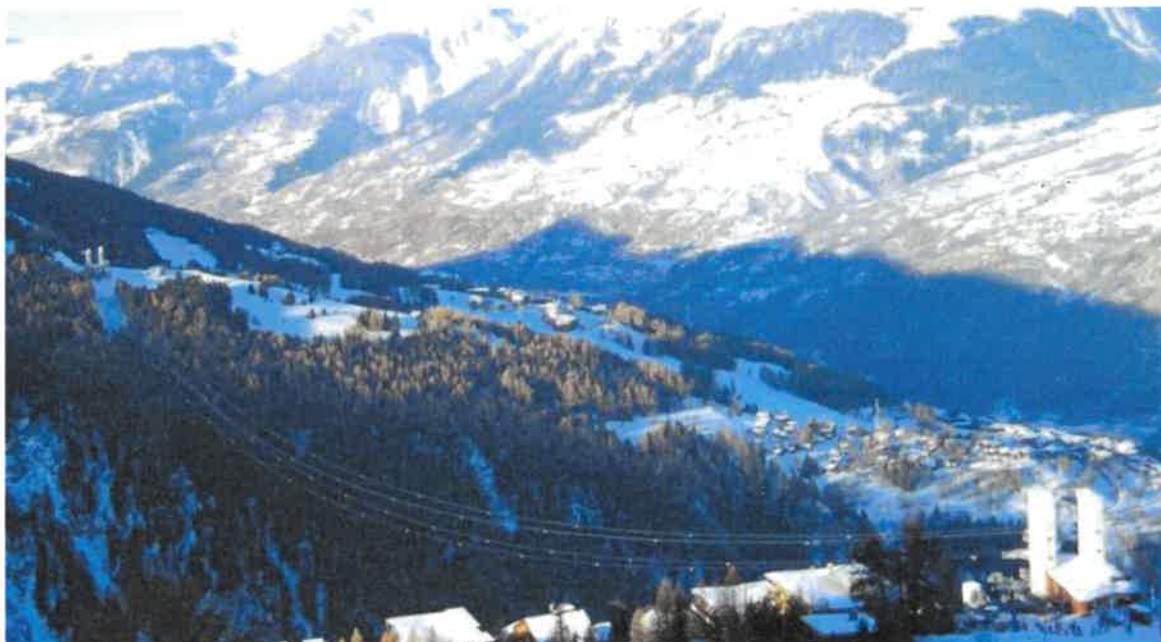
Vue d'ensemble du TPH Vanoise Express
